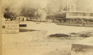
Cuando empezaron los trabajos de transformación
