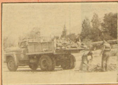
Despejando escombros en la vía pública.
