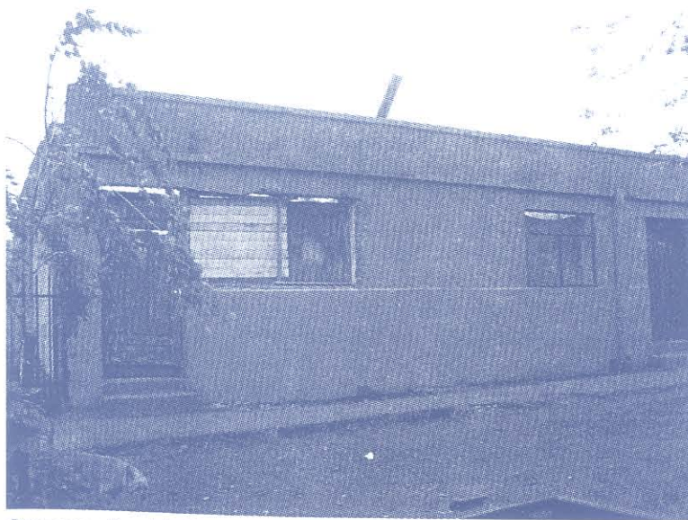
Otra perspectiva de la fachada de la casa de Bulnes.
