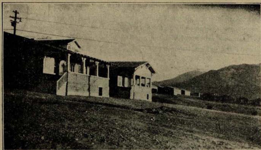
Potrerillos.—Casas de habitación
