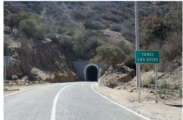
Tunel Las Astas. Fuente: Consultora Pequeñ, 2020.
