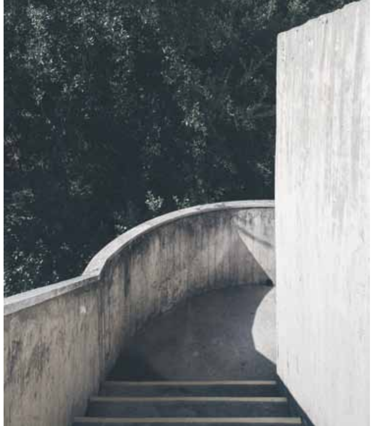
Escalera exterior en hormigón tableado, Pabellón Dormitorios. Fotografía Bruno Giliberto, 2017.
