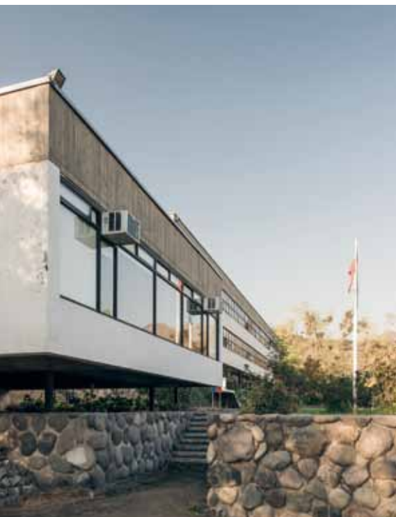
Vista del salón y la entrada desde el ángulo contrario, 2017. Fotografía Bruno Giliberto.
