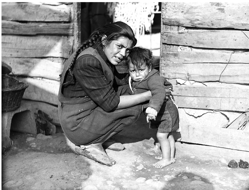
Madre adolescente con su bebé descalzo afuera de una mediagua. Les rodean tierra y rocas a modo de suelo. Casa de madera deteriorada, apenas terminada. Fotografía de Carlos Dorlhiac, colección Dorlhiac, Archivo Fotográfico y Digital, Biblioteca Nacional de Chile.
