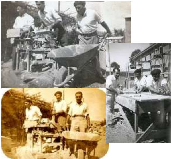
Papá trabajando en la construcción en obras a lo largo de Chile.
