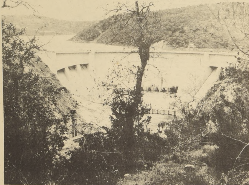
EL MURO de Rapel, aguas abajo, la central de ambalse ubicada en la provincia de Santiago que con sus 35.000 KW es la mayor construida en el país.
