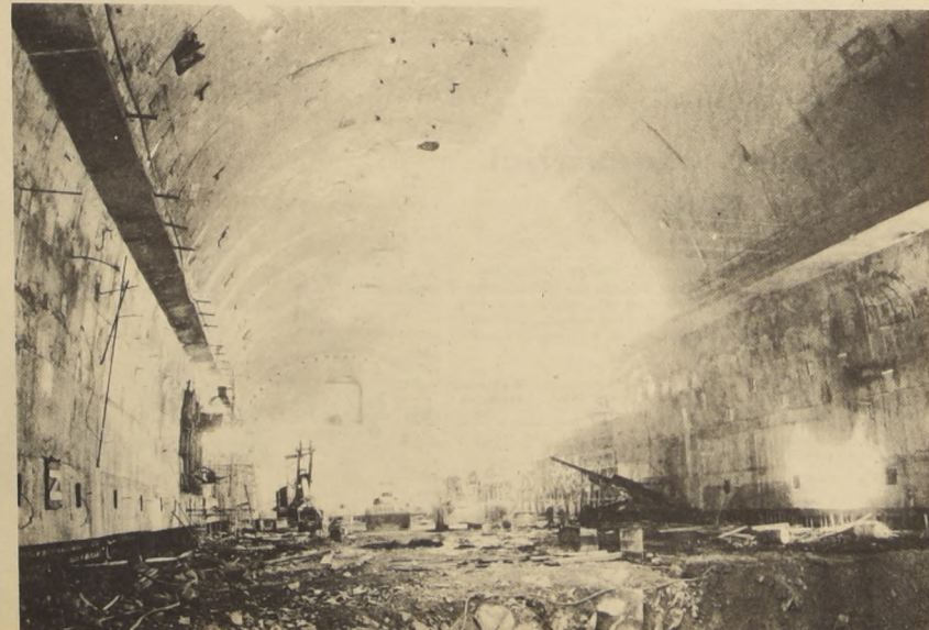
UN ASPECTO de la caverna de máquinas de la Central "El Toro", de 400.000 KW ubicada en el Laja. Las dimensiones de esta caverna son: 40 m. de alto, 25 m. de ancho y 103 m. de largo.
