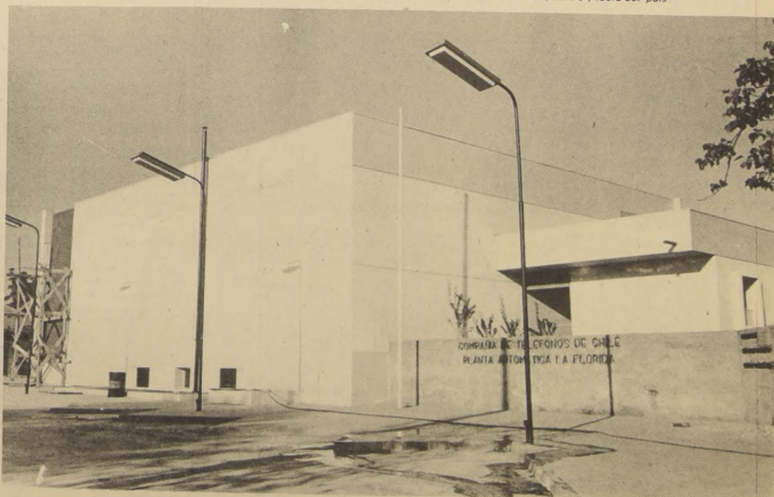
La expansión telefónica que, en 1969 significó instalar más de 32.000 teléfonos y otras obras de mejoramiento del servicio se ha traducido en
