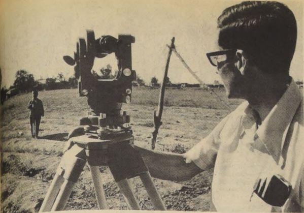
COMPLIENDO EL PLAN DE LA OPERACION de emergencia de la Vivienda, técnicos y empleados de la Corporación de Obras Urbanas iniciaron los trabajos de trazado de sitios y de urbanización en Villa Resbalón N° 2, en Quinta Normal. Al trabajo se han sumado los pobladores. En la fotografía, el Delegado de la Corporación de Obras Urbanas, Manuel Hidalgo, en plena labor de topografía.
