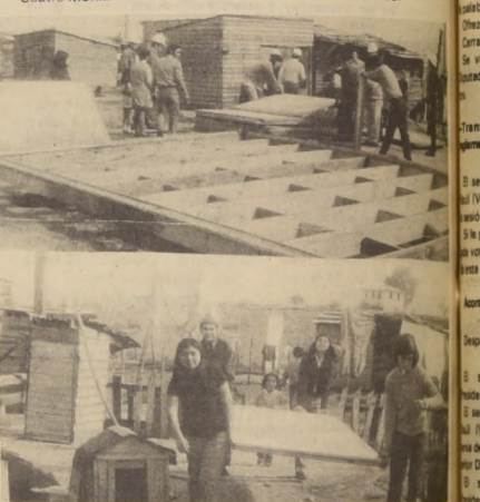
Estos son los entusiastas con que los jóvenes de Valparaíso están cooperando en 16 poblaciones en que por medio del Departamento de CORHABIT, con asesoría técnica de la Oficina de Emergencia y Nuevas Líneas, de Corhabit, se están construyendo 8.000 viviendas en la provincia de Valparaíso con el trabajo voluntario de pobladores que suman su esfuerzo a la tarea. Arriba, trabajos en la población "Oscar Astudillo", de Quilpué; gráfico inferior, estudiantes trabajan en Villa Alemana, población "Santa Elena".
