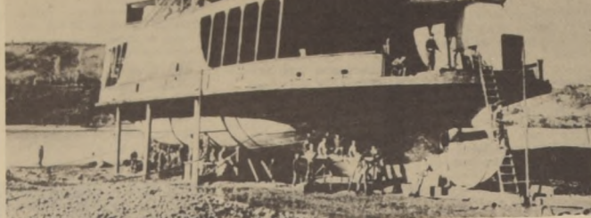
El trasbordador "Alonso de Ercilla" instalado sobre el Varadero de Chingquique que inauguró recientemente la Empresa Marítima del Estado en los momentos que se inician las labores de carena y de reparaciones generales.
