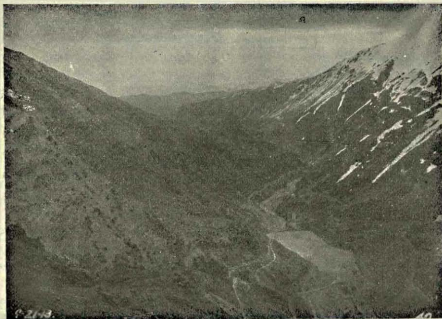
Vista del primer tranque construido en el Coya.—A la izquierda en el fondo de la quebrada, puede verse el acueducto de la quebrada de Agua Dulce que desagua en el acueducto del Coya.
