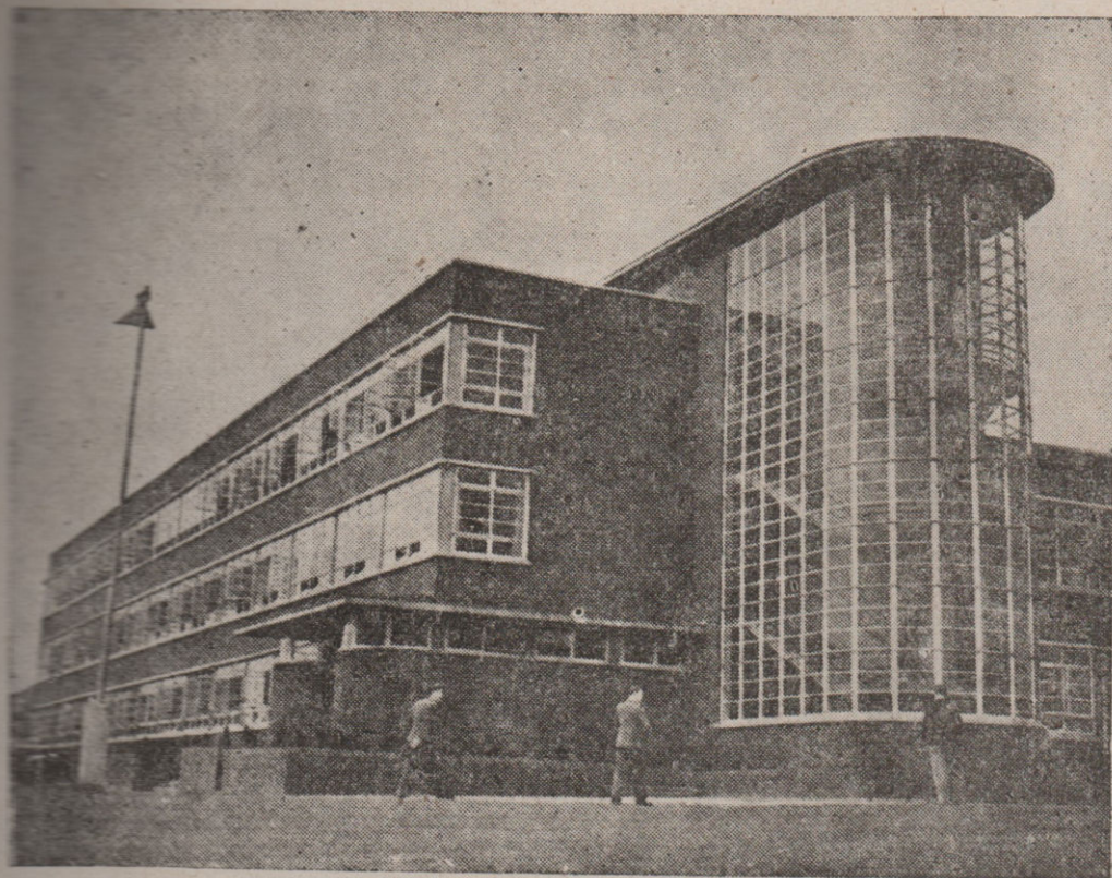
Fachada parcial de un colegio de educación secundaria.
