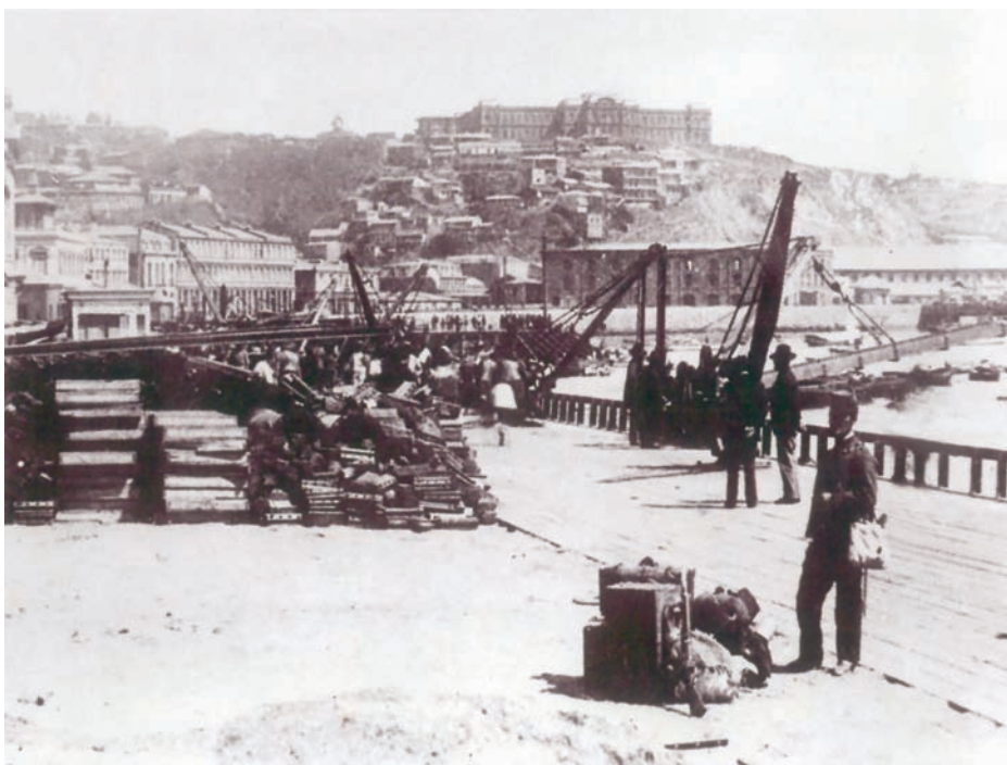
Faenas operacionales en el borde costero. EPV, Memoria visual del puerto de Valparaíso .
