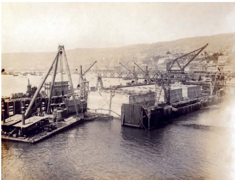
Cajones monolíticos listos para salir de dique seco. EPV, Memoria visual del puerto de Valparaíso .
