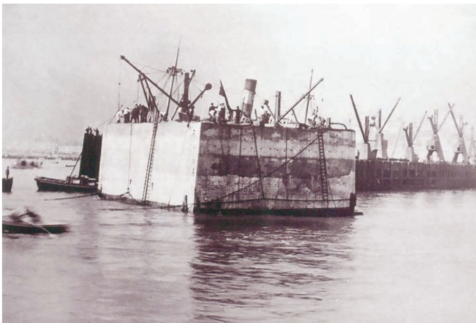
Monolito más grande del mundo, cuya construcción demoró ciento dieciocho días. EPV, Memoria visual del puerto de Valparaíso .
