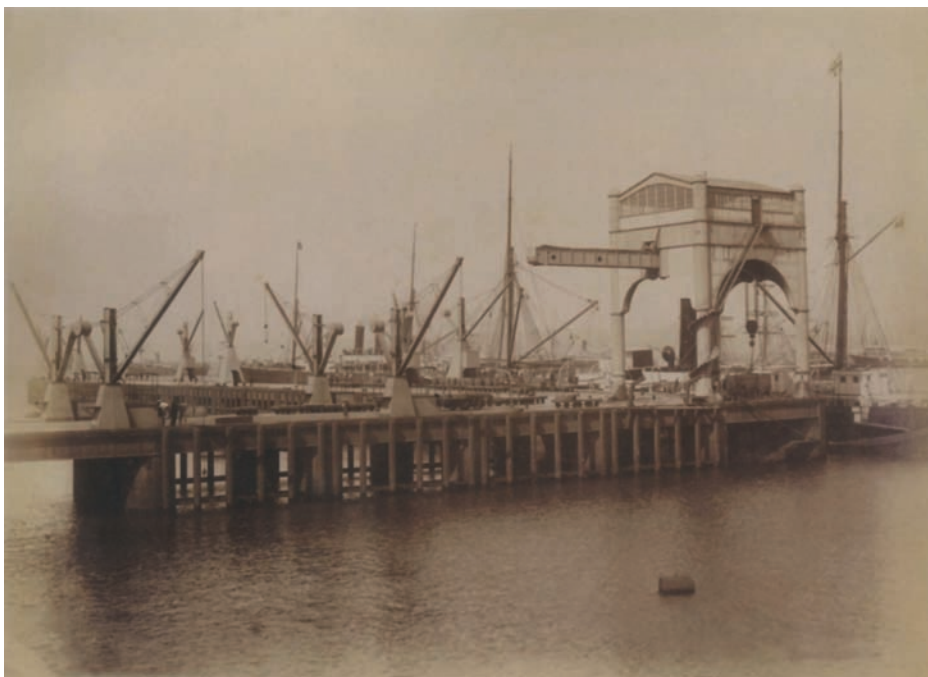
Vista general del Muelle Fiscal. EPV, Memoria visual del puerto de Valparaíso .
