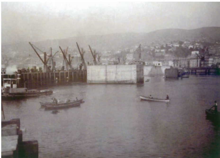
Cajones monolíticos al costado del Muelle Fiscal. EPV, Memoria visual del puerto de Valparaíso .
