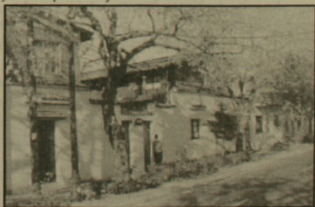
Tipo B: Capellán Abarzúa N° 18, con vivienda construida al fondo del predio sin fachada continua a la calle.
