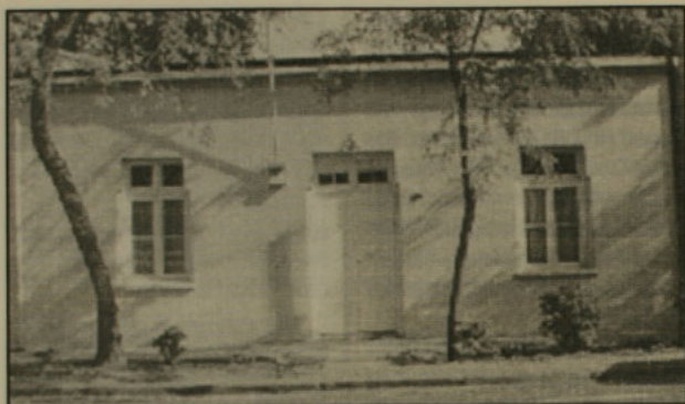
Capellán Abarzúa N° 29. Tipo único de fachada con estuco sobre ladrillo original.
