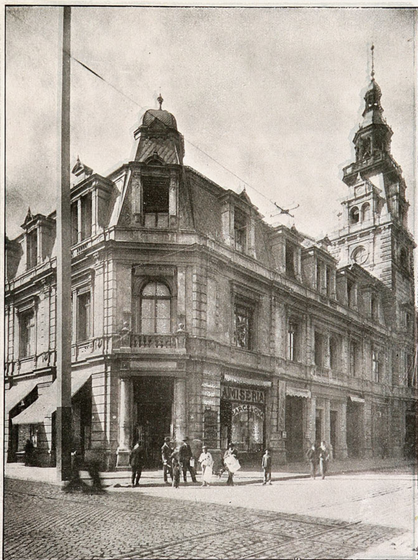
CUARTEL GENERAL DEL CUERPO DE BOMBEROS, CALLE DEL PUENTE, SANTIAGO
