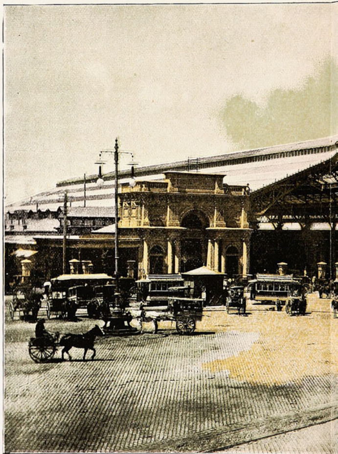
ESTACIÓN CENTRAL DE LOS FERRO
