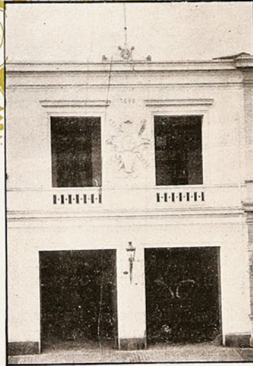
CUARTEL DE LA 12.ª COMPAÑIA DE BOMBEROS AVENIDA CUMMING
