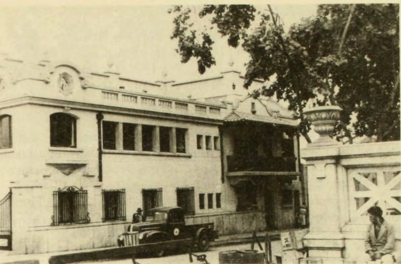
Dirección de Obras Públicas.
