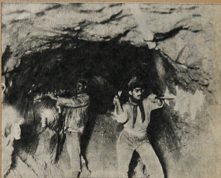
Antiguas labores mineras, de la mina de cobre subterránea más grande del mundo. Ubicada a 70 kilómetros al este de Rancagua, en la zona cordillerana, pertenece a la VI región.
