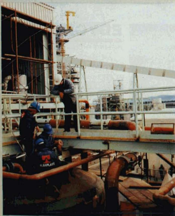
CELPAC: Uniones cañería FRP en planta química, línea de proceso, efluentes.
