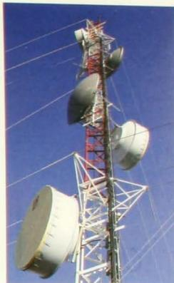
Antenas de microondas utilizadas hasta 2005 para enlaces regionales
