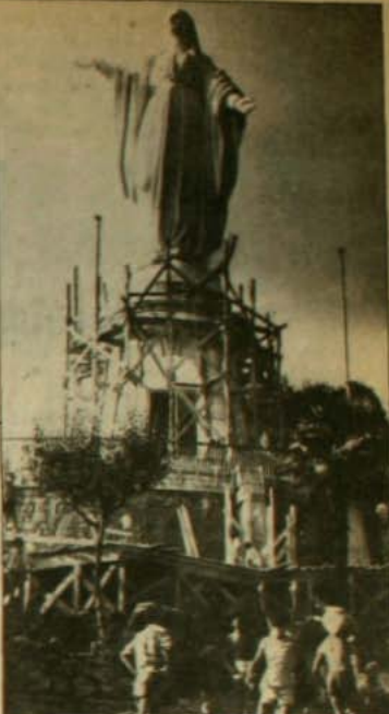
A pesar de que los trabajos están atrasados, la imagen de la Virgen estará despejada de andamios cuando la vea el Papa.
