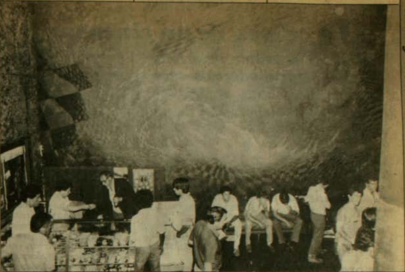
El deterioro está a la vista, aunque la cortina oculte lo peor.
