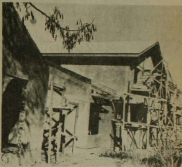
Múltiples construcciones han debido paralizar la obra. Con ello, miles de trabajadores sin trabajo.
