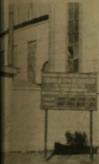
Penco: Sus ex trabajadores tienen la absoluta seguridad que perdieron su fuente de ingreso. El edificio de la ex industria de azúcar se deteriora al mismo ritmo que todo Penco.
