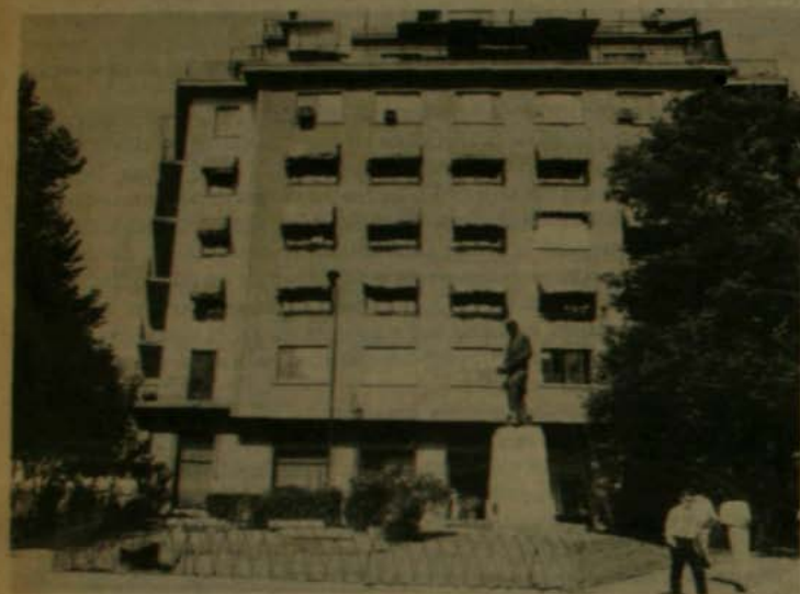
Edificio de Carmona 8, sede de la DC, ya se habla del "Carmengate".
