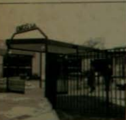
Nueva Oficina Comercial La Granja de EMOS, ubicada en calle Santa Rosa 9130 (altura paradero 25).
