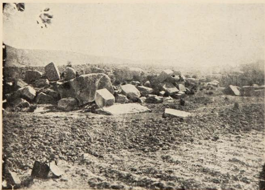
Fig. 2. Ruina de Lloqepaya, vista del Sur
