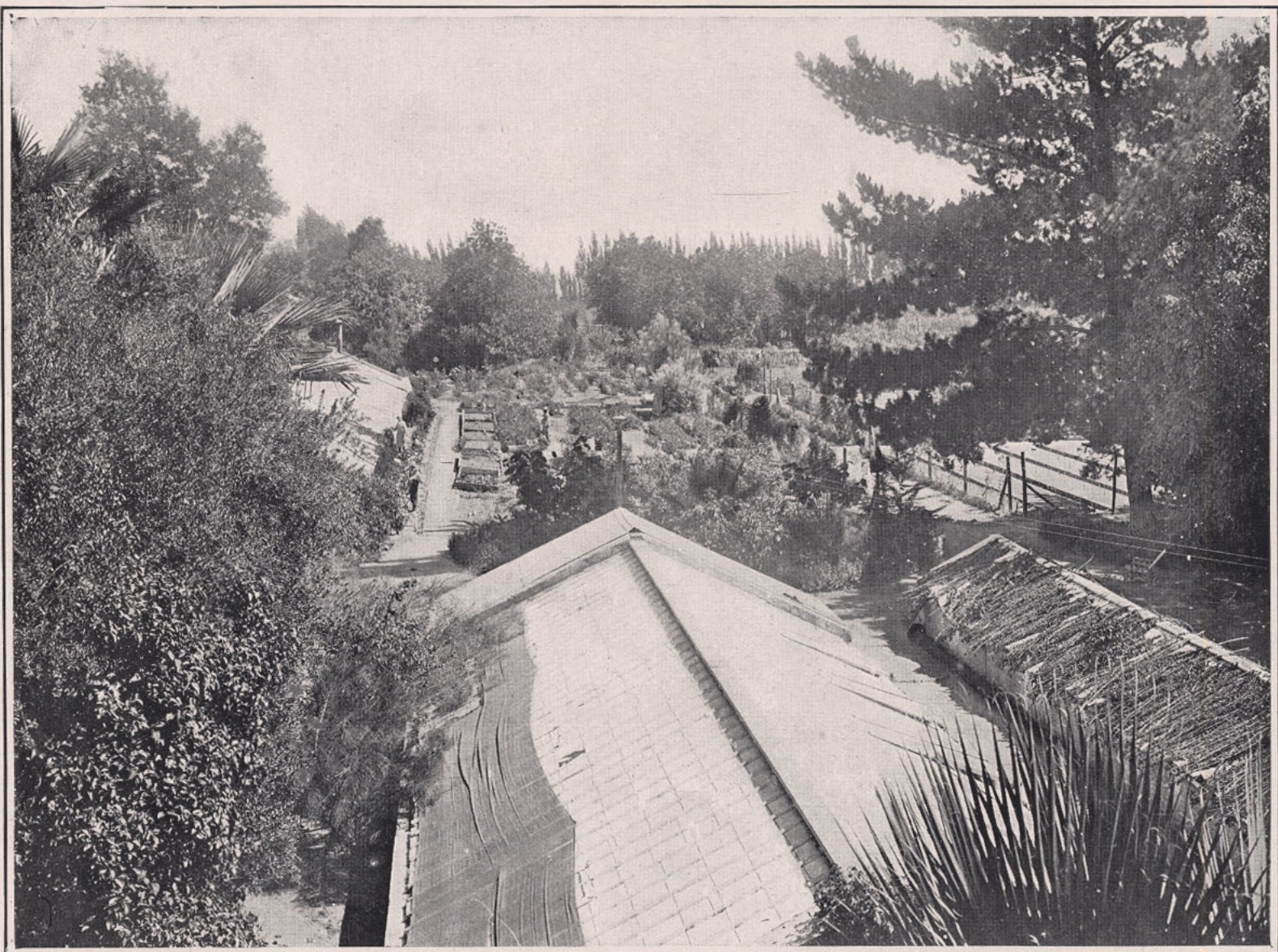
Santa Inés.—Vista de conjunto de la sección parque y conservatorios.
