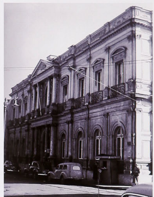
19. LUCIANO AMBROSIO HENAU, PALACIO PEREIRA. RESIDENCIA MANDADA A CONSTRUIR POR LUIS PEREIRA EN TERRENO ADQUIRIDO EN 1872. DECLARADO MONUMENTO NACIONAL EN EL AÑO 1981, SE ENCUENTRA EN AVANZADO ESTADO DE DETERIORO. FUENTE: SEMINARIO DE HISTORIA DE LA ARQUITECTURA, SEXTO AÑO, 1957. ALUMNO : JOSE MANUEL HENRIQUEZ SEVERIN. TEMA: CLAUDIO FRANCISCO BRUNET DE BAINES, LUCIANO AMBROSIO HENAU. DOCUMENTO GRAFICO PROCEDENTE DEL DEPARTAMENTO DE ARCHIVO Y FOTOGRAFIA DE LA UNIVERSIDAD DE CHILE.
