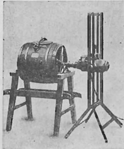
Batidora accionada por motor eléctrico «Elmotor»
