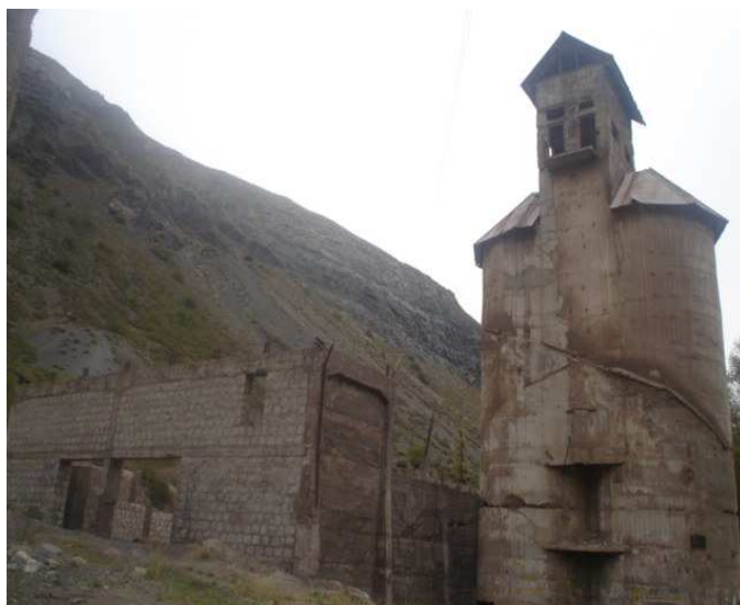
Silo en desuso de la Compañía Industrial El Volcán S.A. Otoño del 2008.
