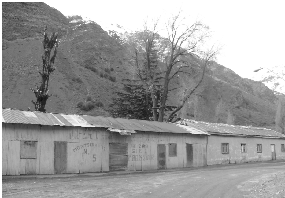
A la izquierda se ubica la antigua pulpería del pueblo, junto a ella se encuentra el edificio que funcionaba como sede del ex Sindicato Industrial Minero Compañía Minera Merceditas. Otoño del 2008.
