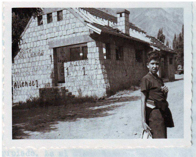
Posta de El Volcán en 1966, antes de su reconstrucción 51 .
