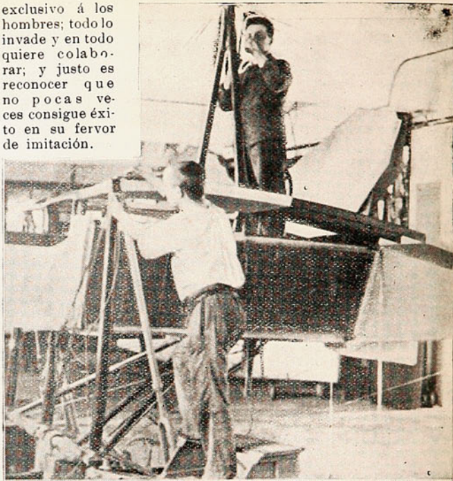
Montadura de los chasis y postura de la tela
