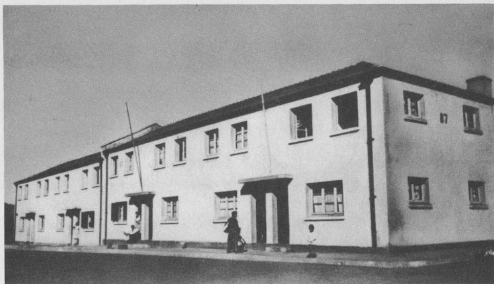
Viviendas para obreros, en Lota Alto.
