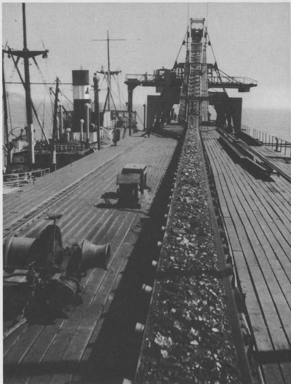
Desde los Silos de Almacenamiento, el carbón es conducido por la cinta transportadora hasta el Cargador Móvil, instalado en el extremo del Muelle de Embarque.
