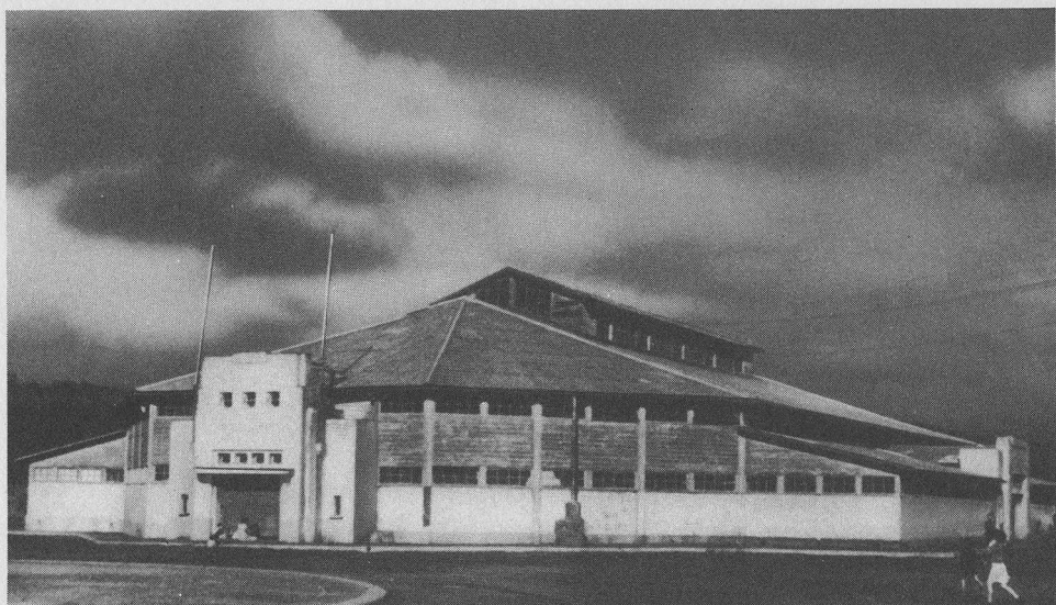
El Gimnasio de Lota Alto, con capacidad para 3.000 personas.
