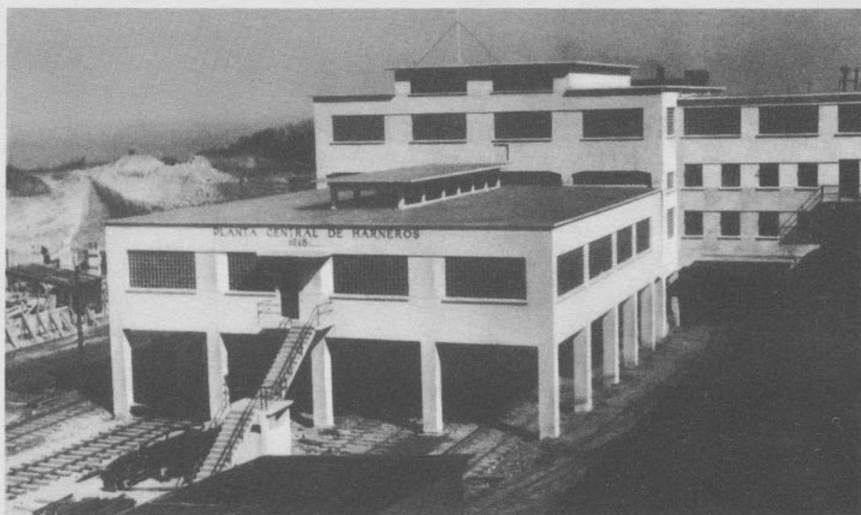
Una vista de la moderna Planta Central de Harneros.
