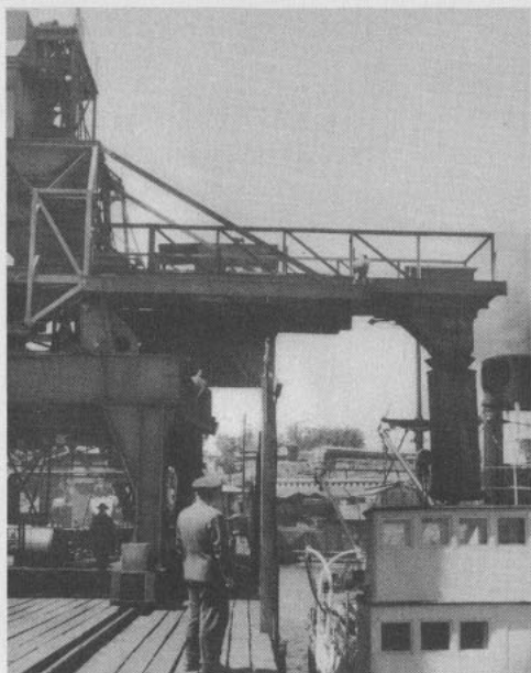
El Cargador Móvil permite abastecer de combustible, rápidamente, las bodegas de los barcos. Desarrolla una capacidad de carga de 600 toneladas por hora.
