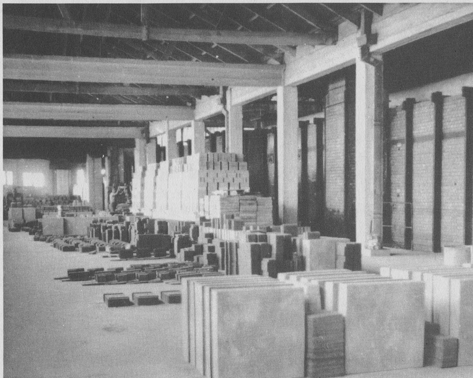
Cancha de secamiento de material refractario.
