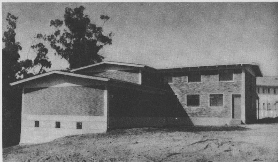
Edificio del Bienestar en Lota Alto.
