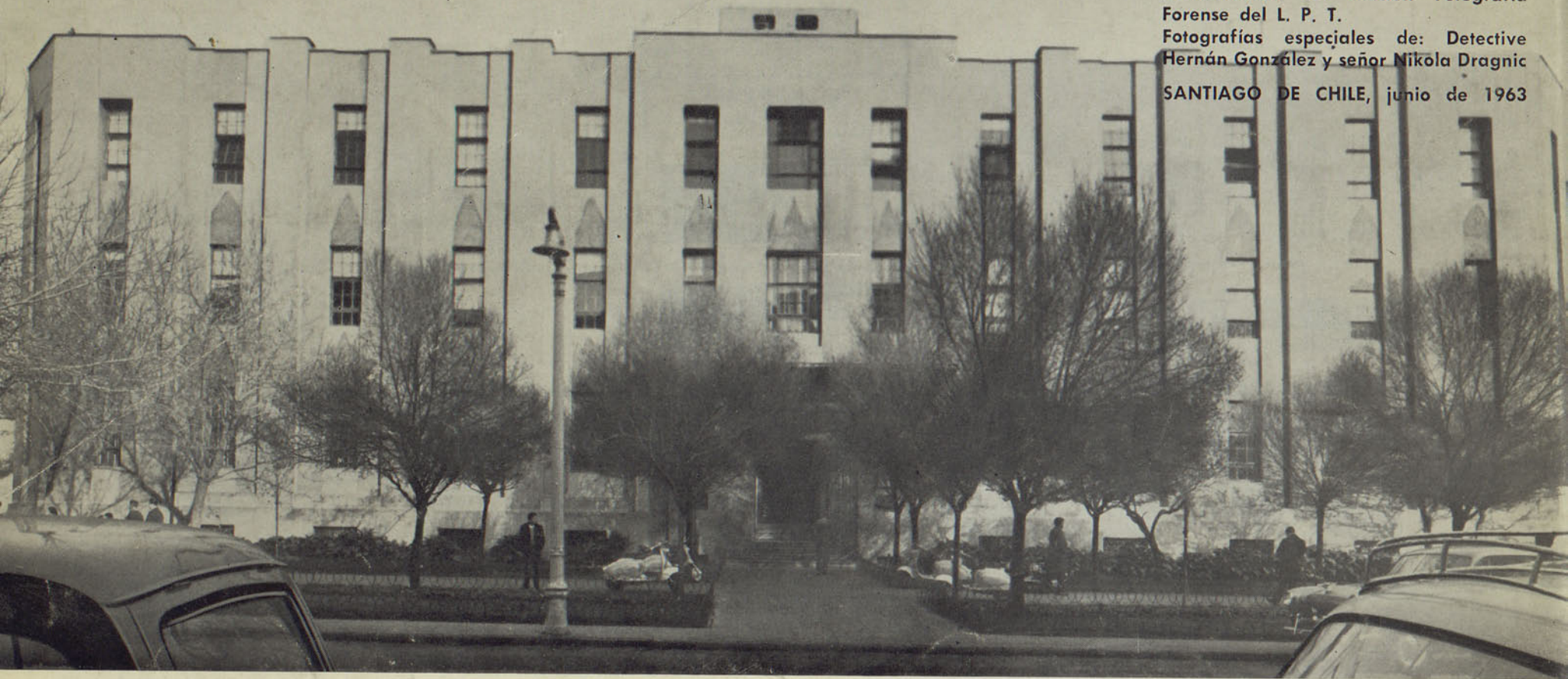
CUARTEL CENTRAL DE INVESTIGACIONES, SANTIAGO
