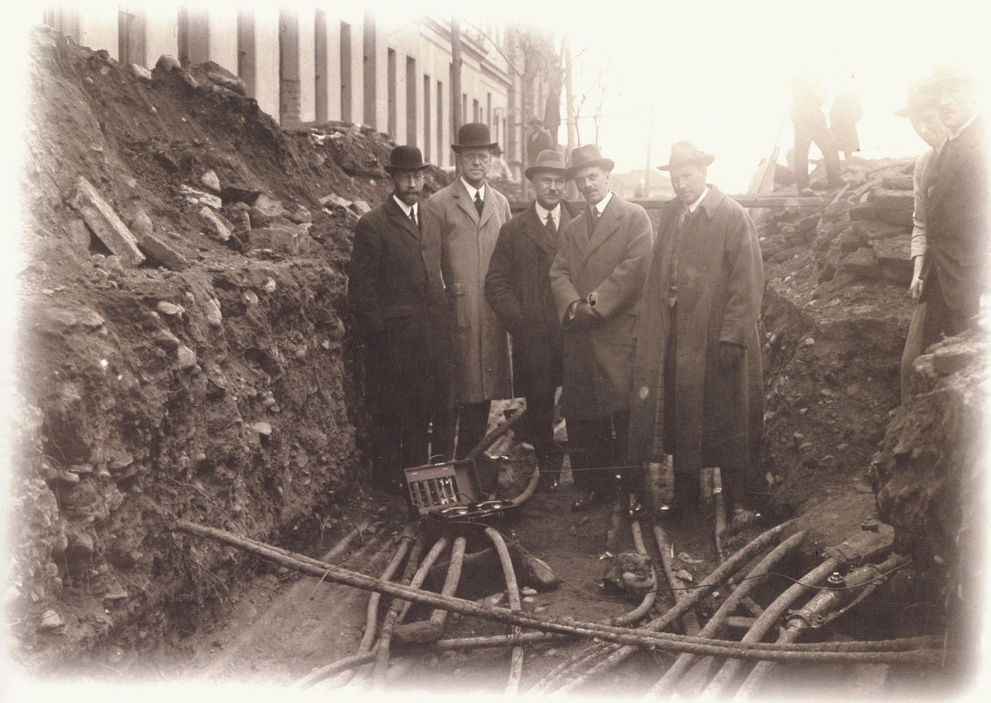
D DETECTANDO UNA FALLA EN LA RED SUBTERRÁNEA.
