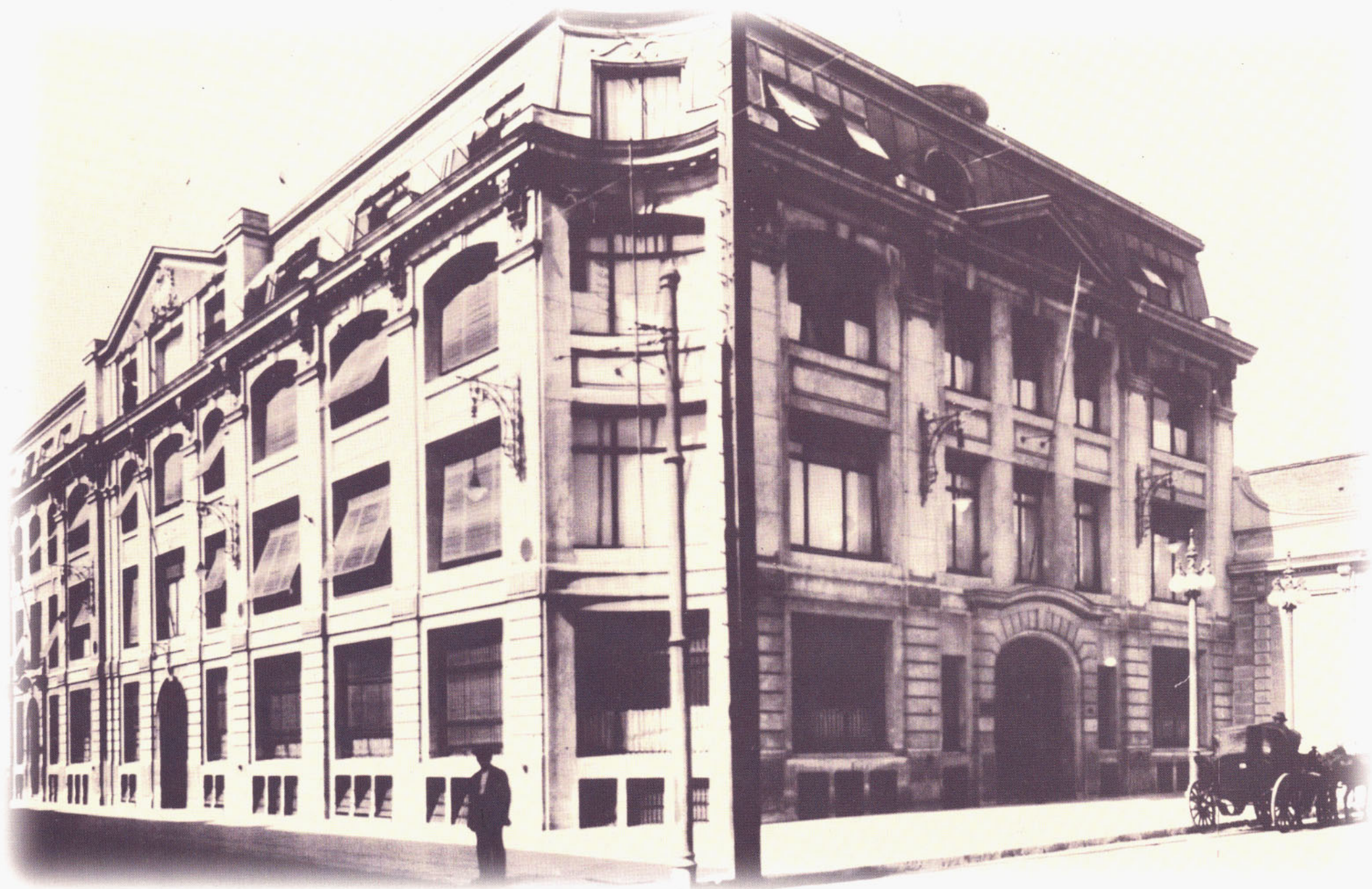
68 SEDE PRINCIPAL DE LA COMPAÑÍA CHILENA DE ELECTRICIDAD, SANTO DOMINGO CON SAN ANTONIO.
