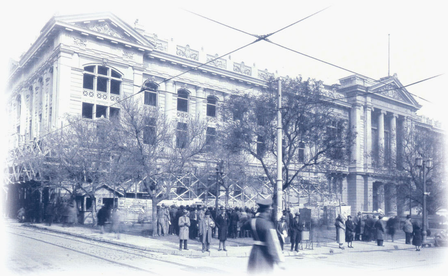
LOS TRIBUNALES COMPLETAN SU CONSTRUCCIÓN DEFINITIVA EN CALLE BANDERA CON COMPAÑÍA.
