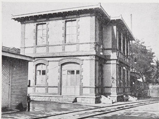
Pabellón Sanitario Central, de la 2.ª Sección de los Ferrocarriles del Estado
