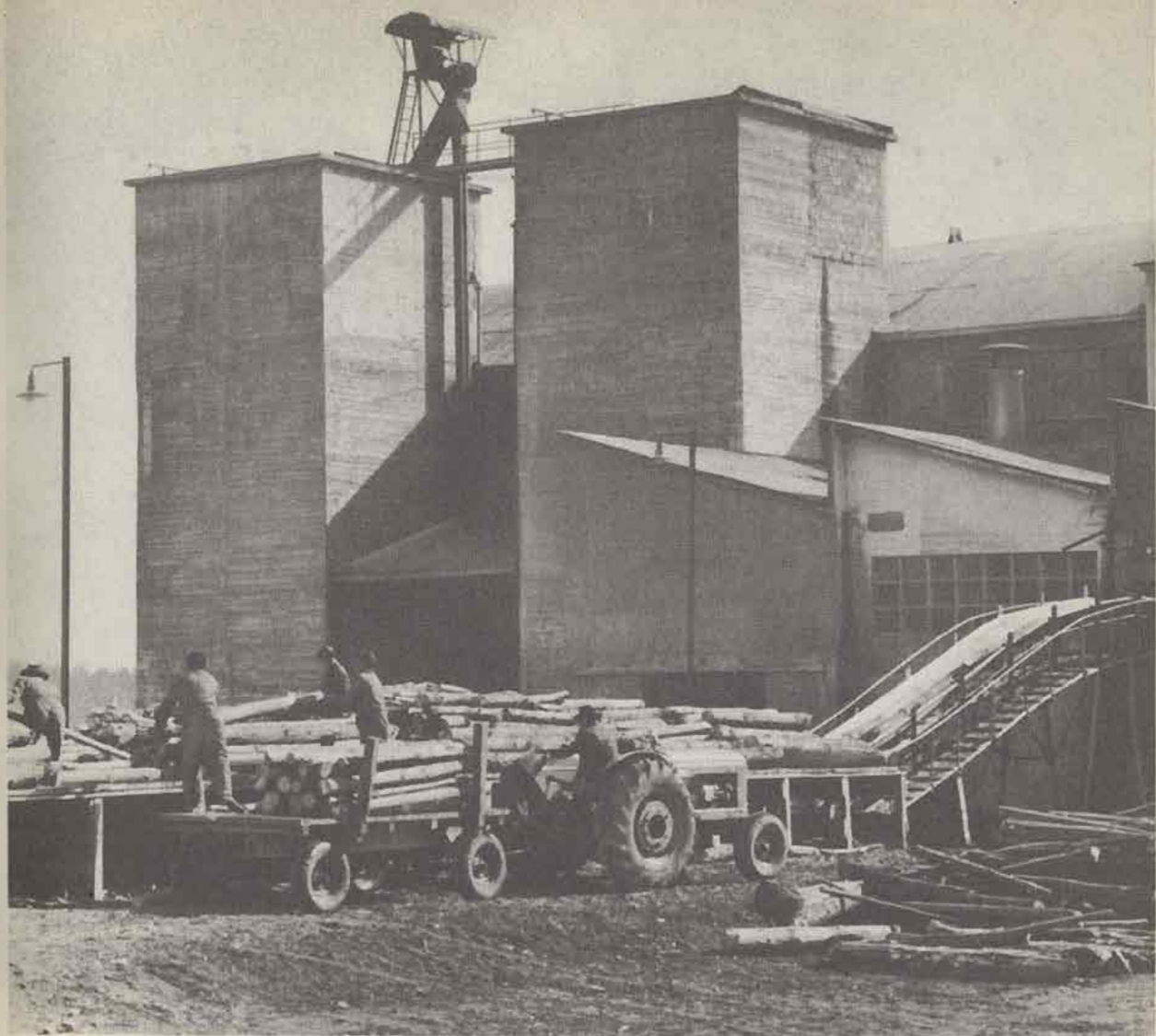
Vista parcial de la planta de madera procesada de Cholguan.
