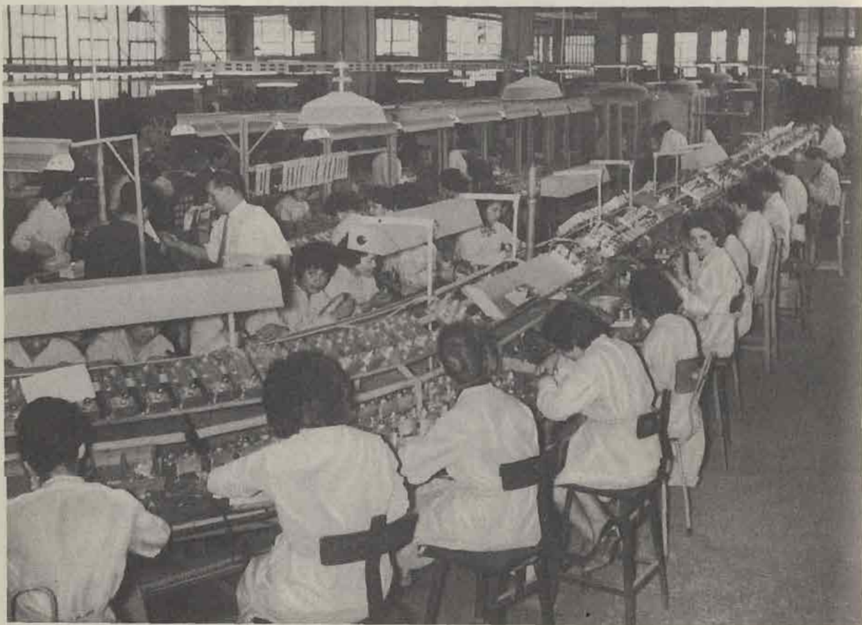
Línea de armadura de la Corporación de Radio de Chile, S. A.
