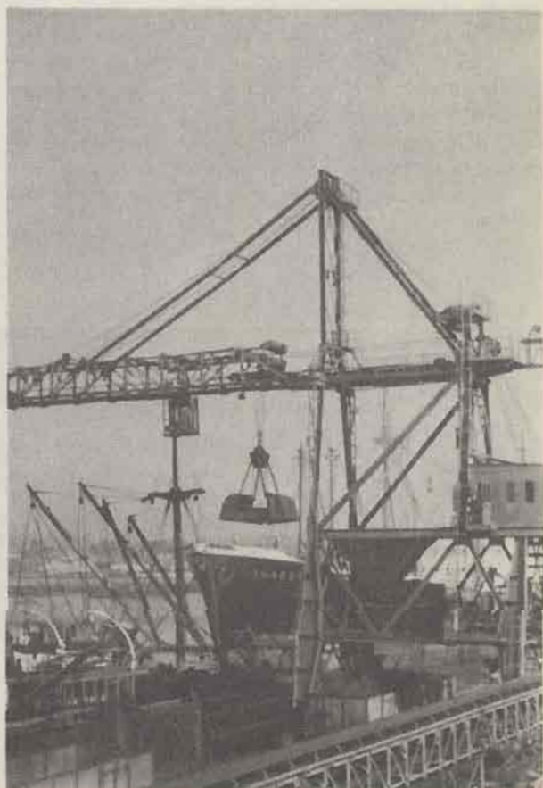
Planta mecanizada para carga y descarga de carbón en San Antonio.
