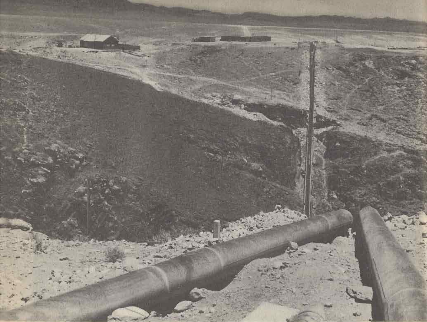
Línea de aducción para el agua potable de Antofagasta.
