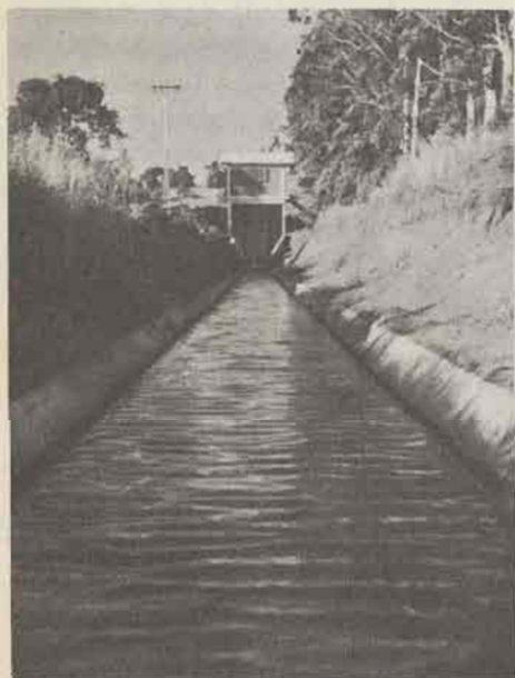
Canal de captación.
