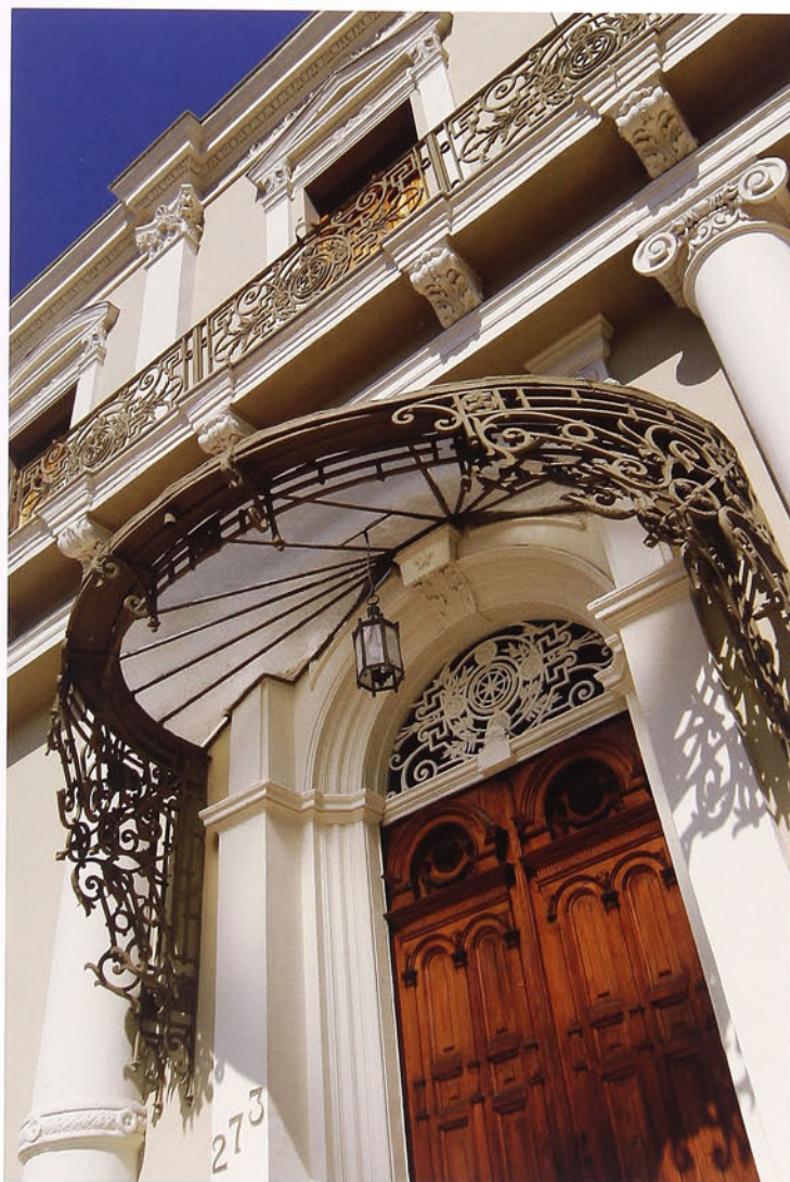
Elaborada marquesina que enmarca y protege el acceso, la cual tiene el mismo diseño que los elementos metálicos exteriores.
