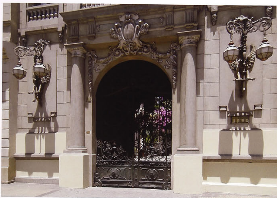
Acceso desde la calle a través de un portón de forja y fundición, enmarcado por un gran arco de medio punto, flanqueado por dos magníficas lámparas.
