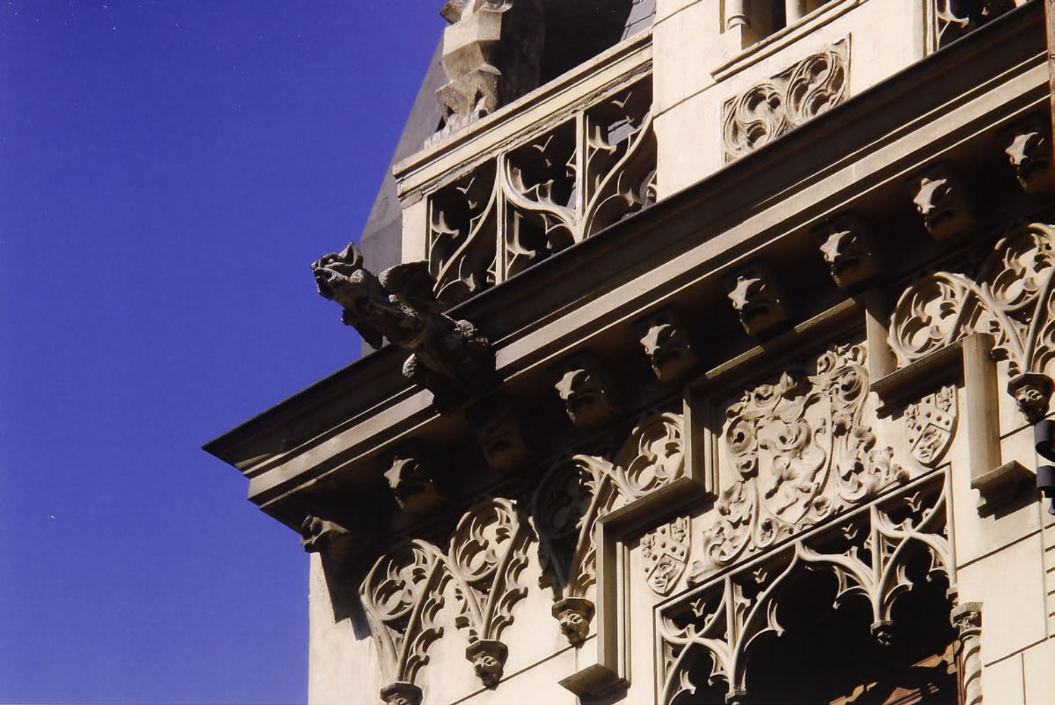
Detalle del encuentro entre el tercer piso y la cubierta, con sus cornisas, rosetones y gárgolas.
