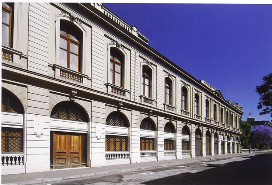
Acompasada y serena fachada hacia la calle San Ignacio, donde se encontraban los accesos de servicio y cocheras. El primer piso fue diseñado para albergar locales comerciales.
