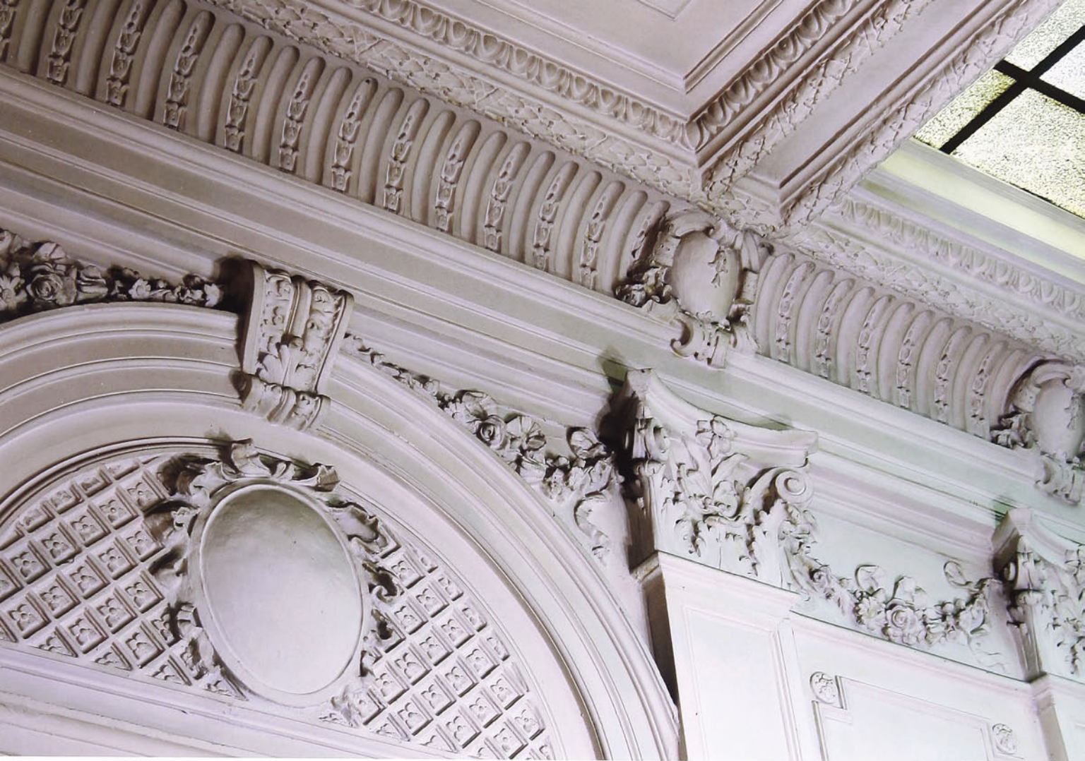
Detalle de cornisa y claraboya del hall central.
