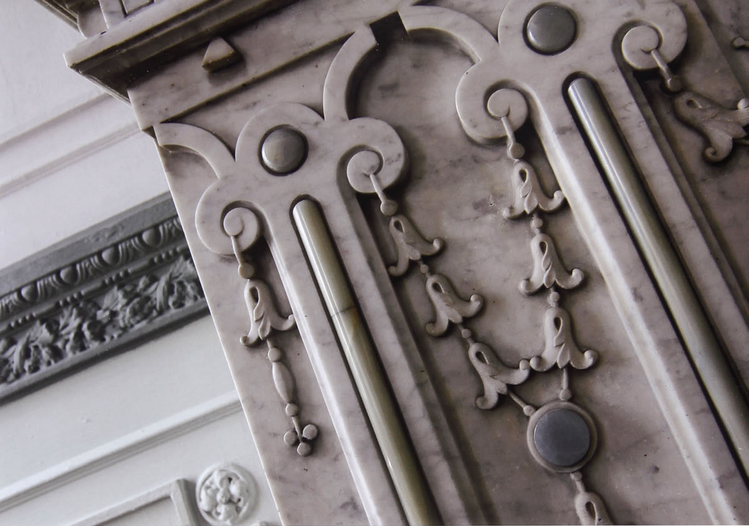
Detalle de la chimenea que destaca por tener incrustaciones de variados tipos de mármol.
