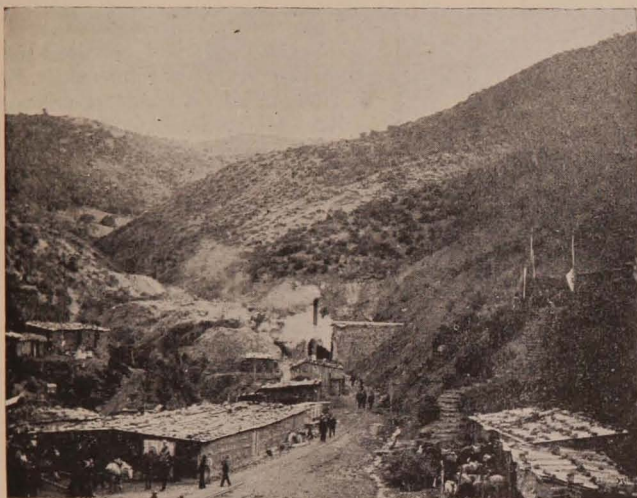
Instalacion de aire comprimido para mover las perforadoras de la boca oriente
