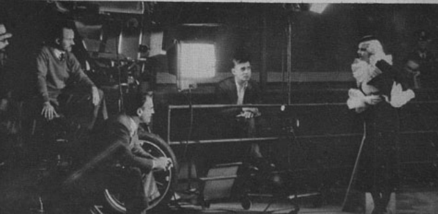
Muy a menudo es necesario construir rieles por los cuales corra fácilmente un carrito que lleva la cámara montada en él. Así se hizo por ejemplo, mientras se estaba filmando la cinta "Cambia el mundo", a la que pertenece esta fotografía. Obviamente, además, que el set que representó un bosque es artificial; en primer término puede verse la construcción simulada de un árbol. (Foto Warner Brothers)
