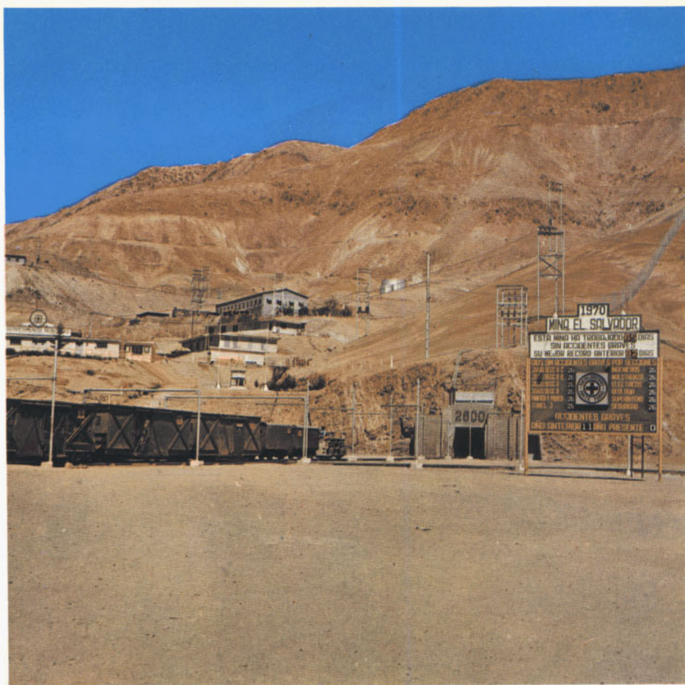
Entrada a la mina en el túnel 2.600 de El Salvador
