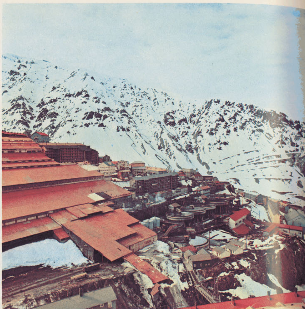
Vista parcial del Campamento en Sewell
