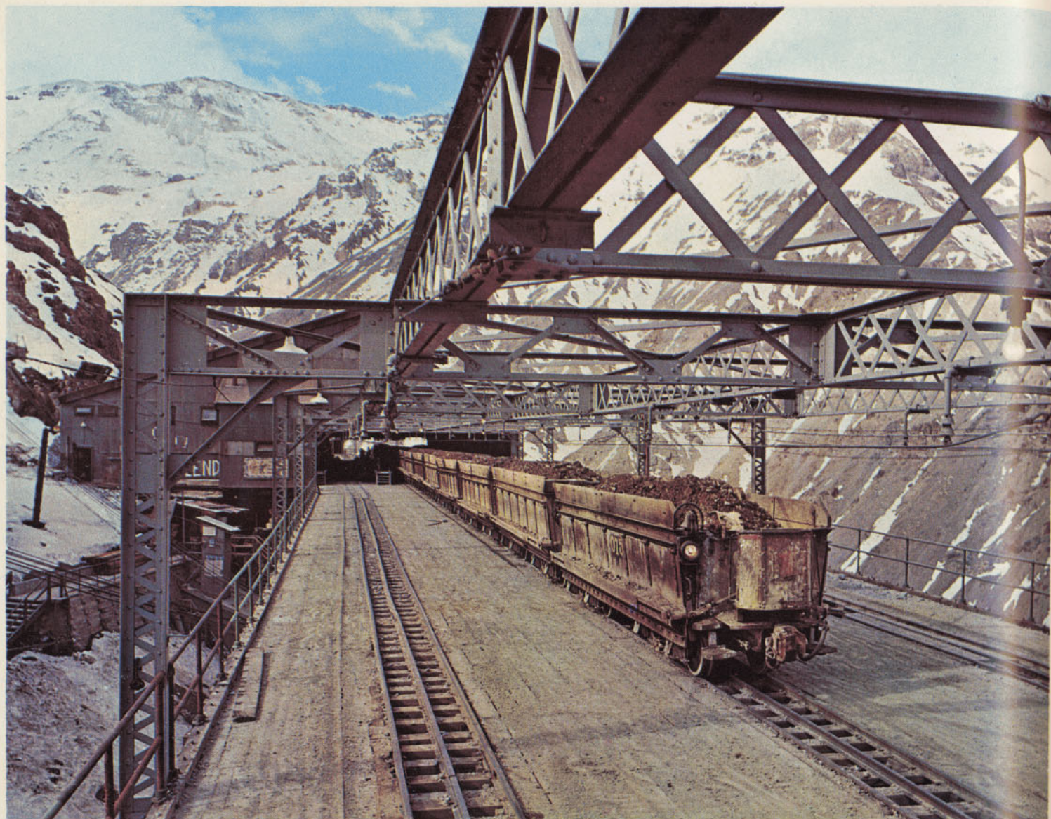
Punta de Rieles, salida de la Mina con los carros cargados con minerales con capacidad de 25 toneladas cada uno, en Sewell
