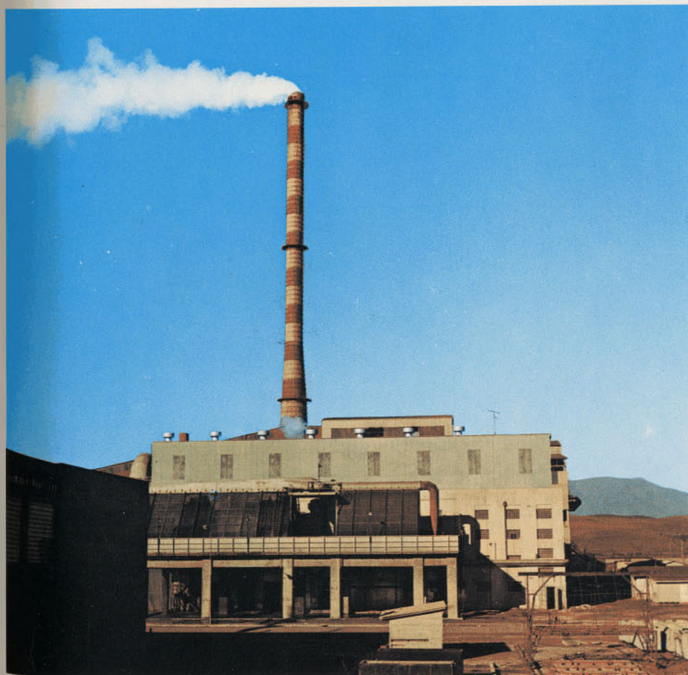
Chimenea de la Fundación Ventanas. Se eleva a 132 metros de altura, es como un símbolo de la Fundación
