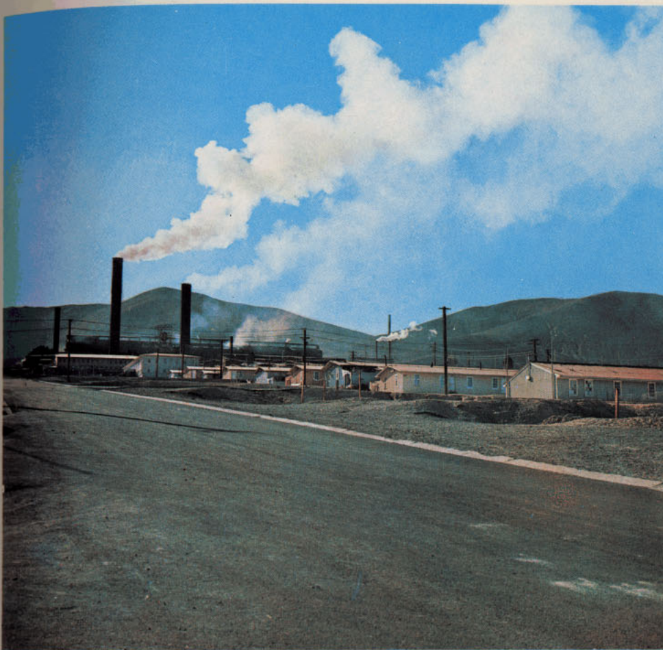
Parte del Campamento de Potrerillos con las chimeneas de la Fundición
