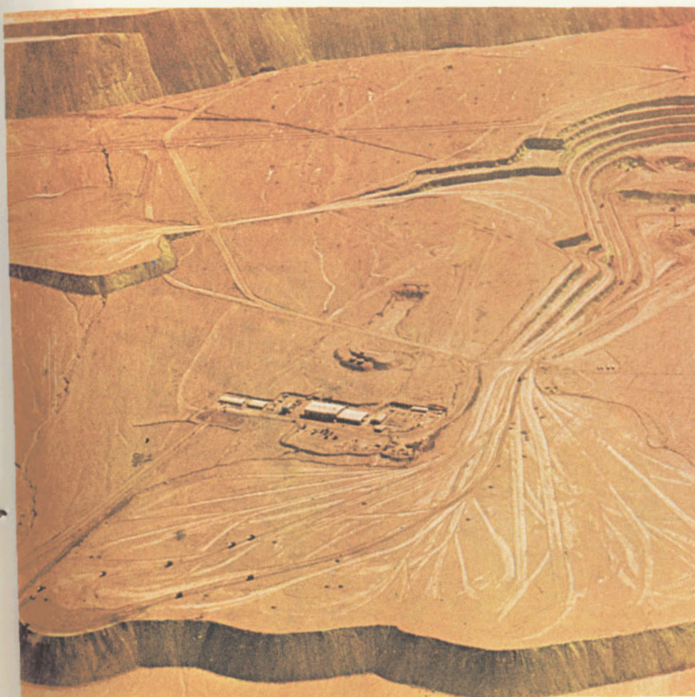
Vista de los primeros trabajos de formación de la mina Exótica, en Chuquicamata
