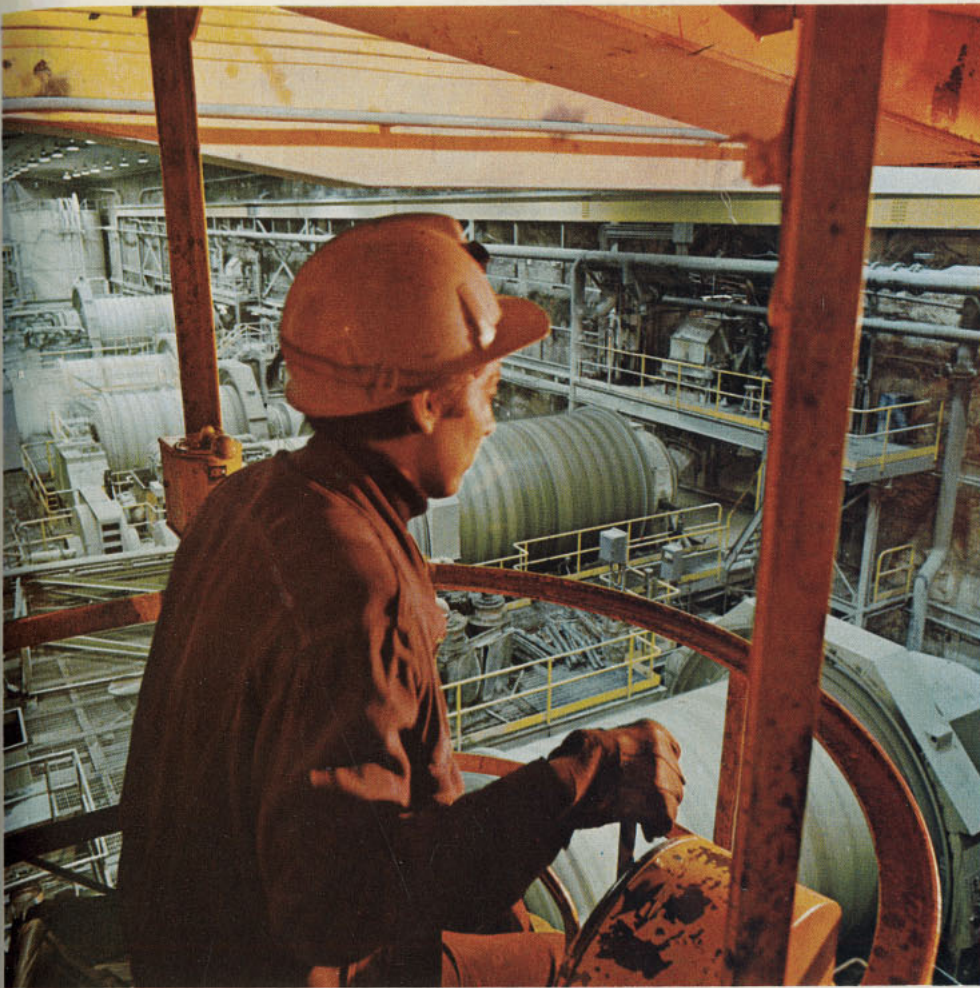
Técnico operador laborando en la dirección de la Planta de Servicios. Cía. Minera Andina, S.A., en Río Blanco
