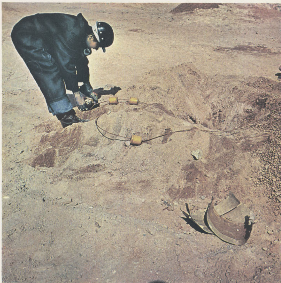
Un trabajador en la faena de preparar la explosión diaria de la Mina
