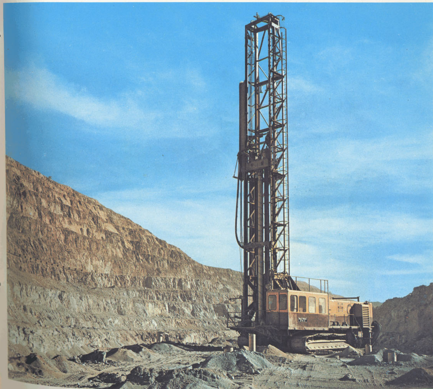
Máquina haciendo excavaciones en Chuquicamata
