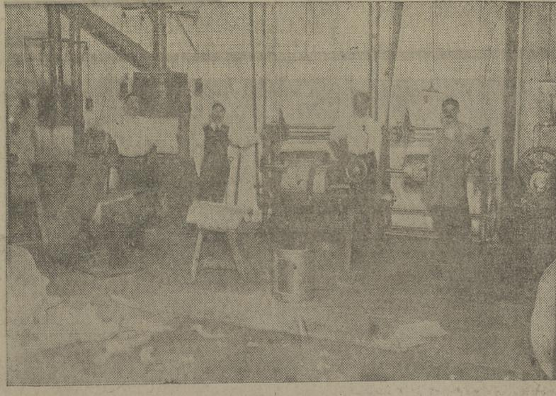
La fundición de las páginas en moldes adaptables á los cilindros impresores
