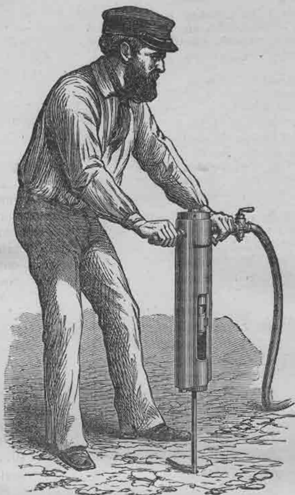
PERFORADORA WARSOP, TRABAJANDO VERTICALMENTE.
