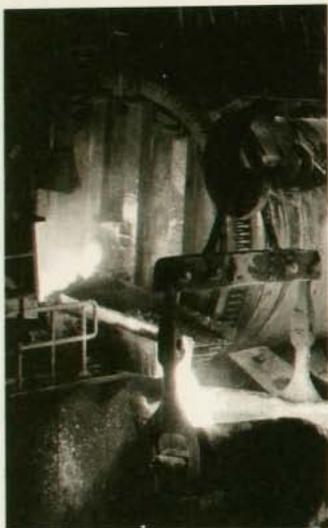
Obtención de metal blanco (75% de concentración de cobre) en el Convertidor Mejorado Tipo Teniente.
