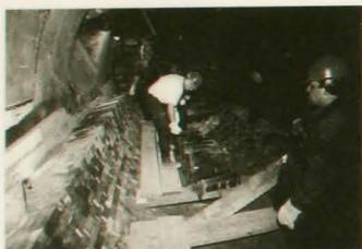
Reparación del Horno Convertidor Teniente, que está cubierto interiormente por ladrillos refractarios.
