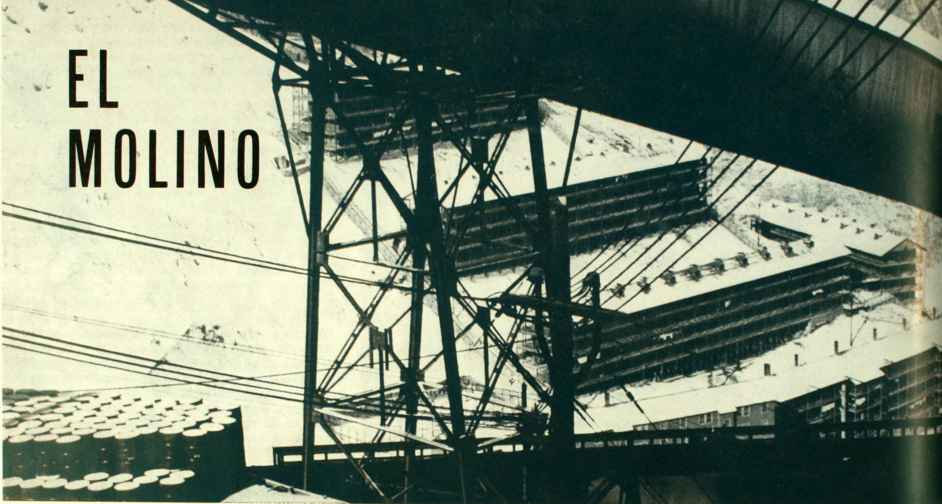
El mineral procedente de la mina es vaciado de los carros del ferrocarril en buzones y llevado por gravedad hasta las unidades chancadoras y de molienda primaria, a los molinos de bolas Marcy y Hardine, a la planta de flotación, a las instalaciones de re-tratamiento, a la sección filtros y finalmente el andarivel de 6 1/2 kilómetros conduce los concentrados de cobre hasta la fundición de Caletones.
