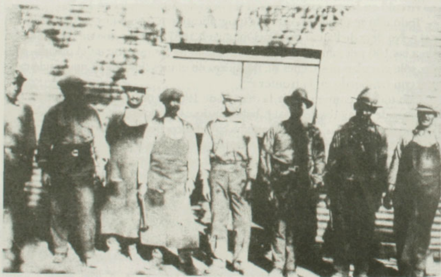
Grupo de caldereros en Casa de Máquinas de Estación Central. Personal de Estación Central.
