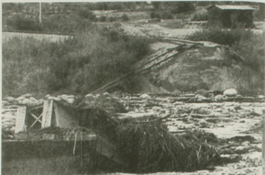
Puente destruido km 41.
