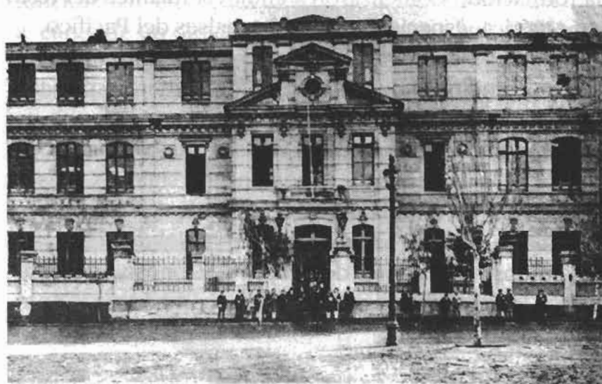
Edificio del Instituto Pedagógico en la Alameda esquina Cumming.
