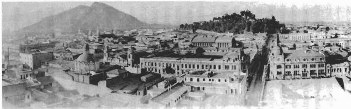
Intersección de las calles Moneda, que muere en el cerro Santa Lucía, y Estado.
