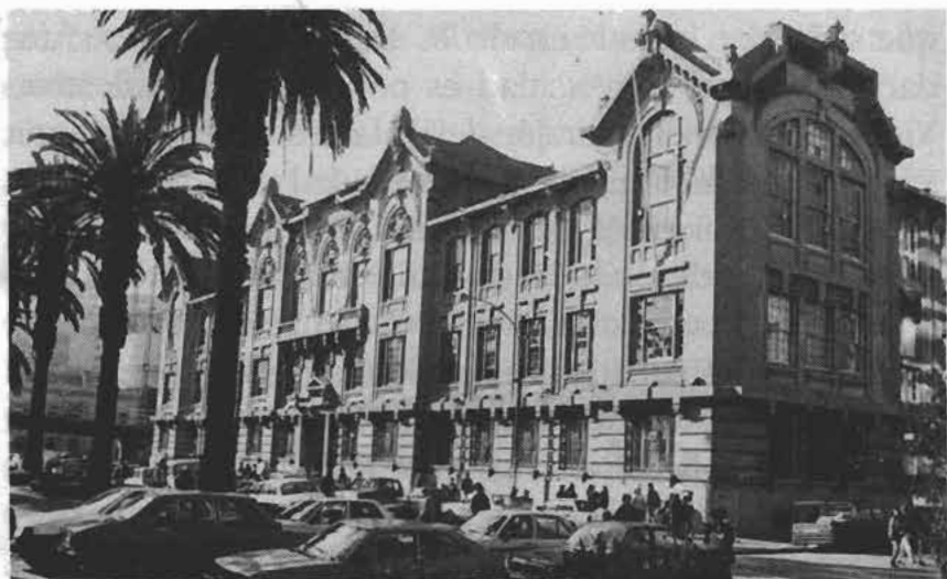
Edificio de la Universidad Católica de Valparaíso.
