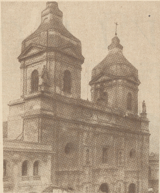
La iglesia de Santo Domingo, fachada de piedra y granito, construcción muy sólida, amplia y llena del colorido de esa época.
