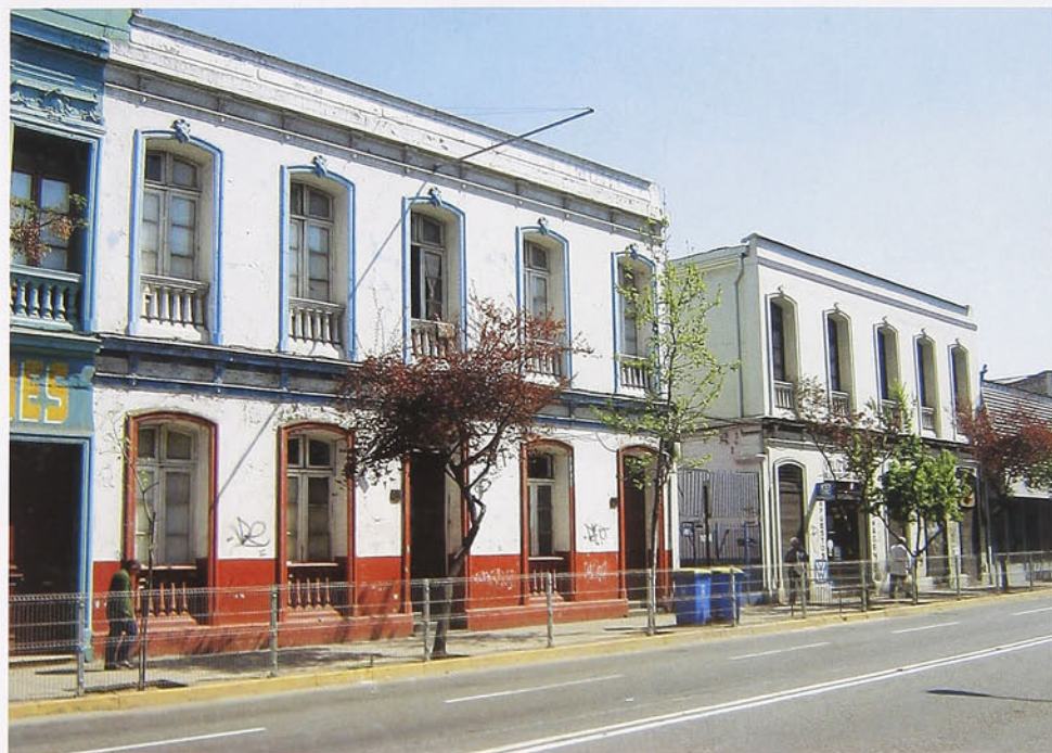
Cité en calle Almirante Latorre 85-93.
