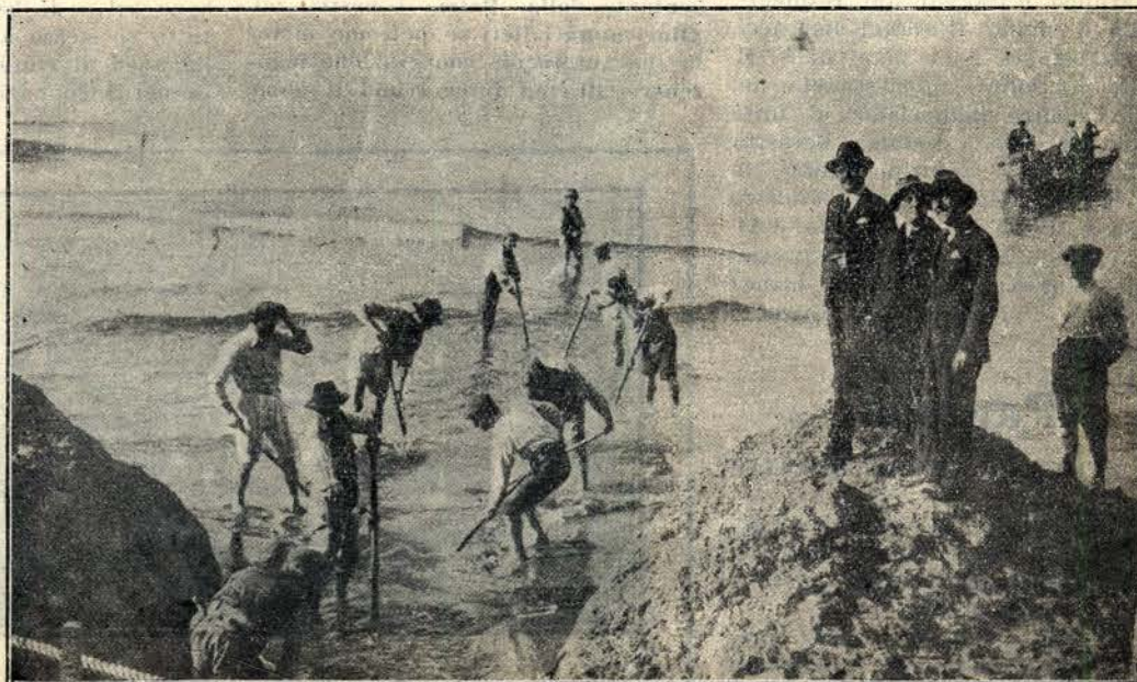
La posa del Cable diretto fra l'Italia e l'America. Gli ultimi lavori di unione alla Centrale italiana
