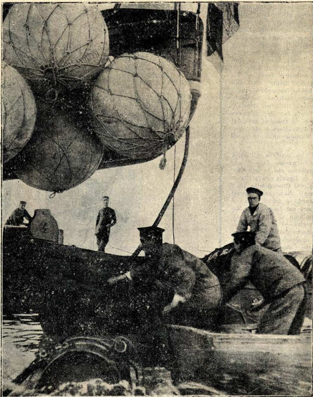
Il cavo telegrafico Italia-America è un fatto compiuto: La squadriglia posa cavi ultimi tratti per la grande inaugurazione che avrà luogo il 12 Ottobre 1925
