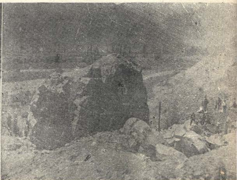
Un macigno lanciato dall'esplosione alla distanza di 200 metri dal luogo dello scoppio.
