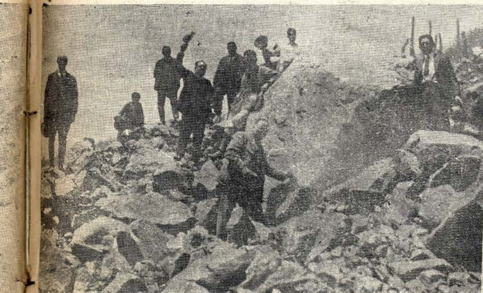
Il Cav. Corte mentre incendia una mina supplementare applicata ad una roccia in pericolo.
