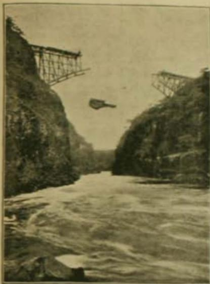
tosa de la corriente, ha sido preciso trabajar el puente en el aire simultáneamente por ambas orillas. Cada pieza del puente va siendo empujada hácia el centro desde la orilla respectiva. Los obreros que trabajan colgados en el aire a cien metros de altura, tienen debajo una red de salvamento que no se vé en la fotografia. Al caer ruedan por ella hasta el gran cesto de mimbres que se ve en el centro.
