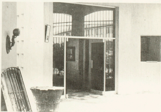
Detalle del acceso del ala sur con el marco y puerta de cristal polarizado en marco de aluminio.
