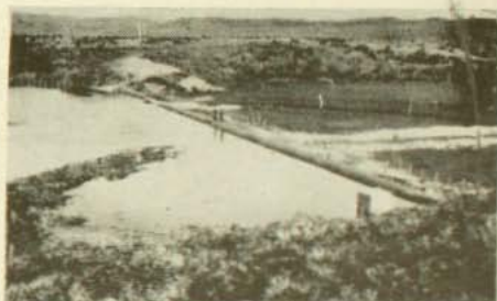
Vista general de la toma de agua y filtro.
