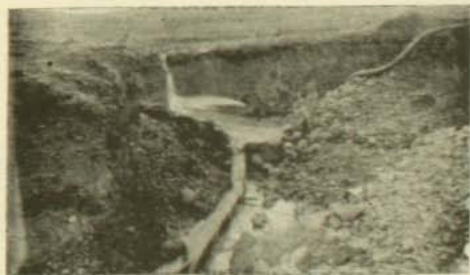
Canaleta de un lavadero de oro.
