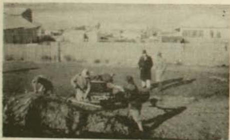
Autoridades comunales vigilando el trabajo de nivelación de calles.
