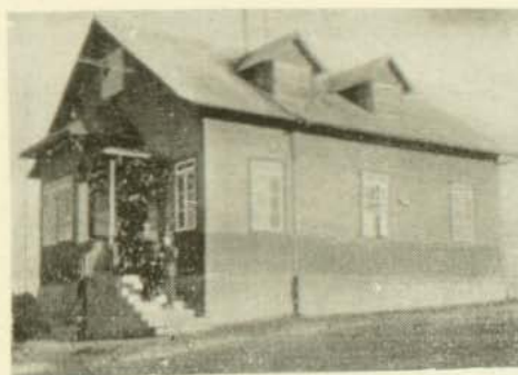
Edificio donde funciona la Central Telefónica.
